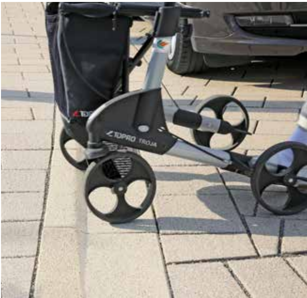
2 cm Höhendifferenz für erleichterten Übergang
