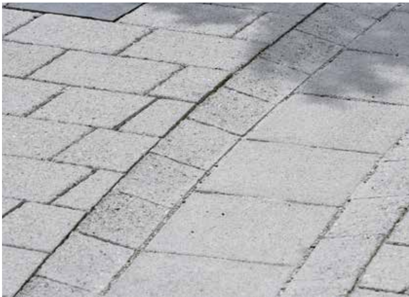
Mit einer Rinnentiefe von 1,5 cm und einer Rinnenbreite größer als 45 cm erfüllt TESSINA® Rand- und Rinnenstein 2a die Anforderungen der DIN 18024-1.
